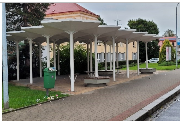
Zastrešenie autobusovej stanice, Bílovec, ČR
