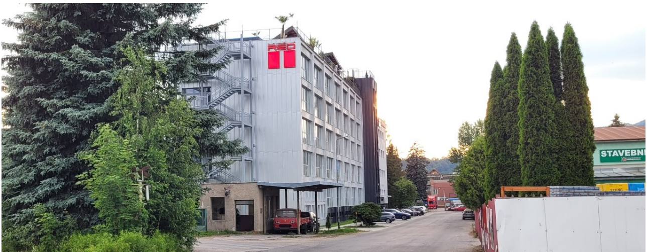
Obr. 59: Double Red Cars Museum v areáli Mostáreň v Brezne – zmena využitia objektu, strešná terasa s rastlinami.
