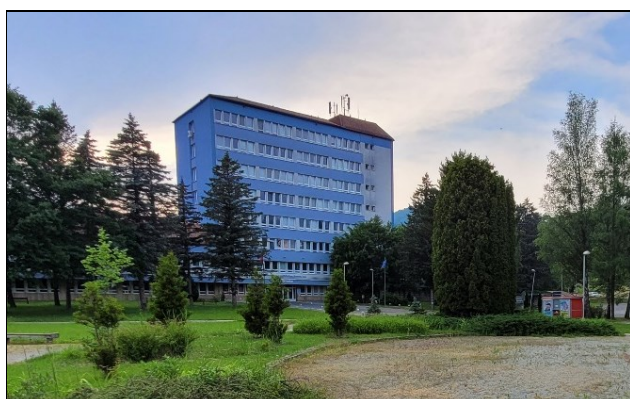
FVE na strechu nemocnice
