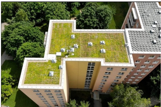
Zelená strecha bytového domu v Brne, Bohunicích (ČR)
