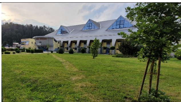
Hospodárenie s dažďovými zrážkami zo strechy zimného štadióna (zdroj vody pre ľadovanie, vegetáciu ap.)
