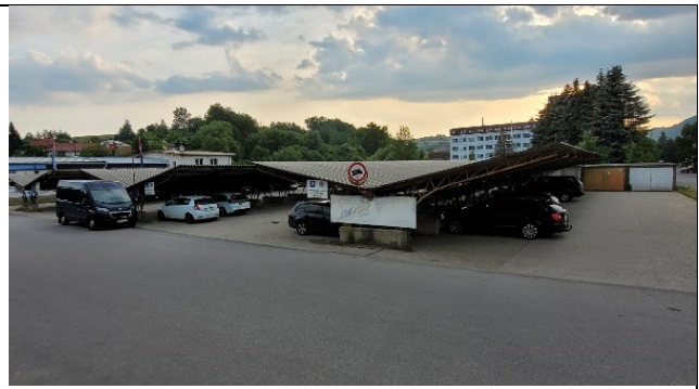
Priemyselný areál Mostárenska – vysadenie stromov zo severnej strany parkoviska tieňom neovplyvní využitie striech pre fotovoltaiiku.
