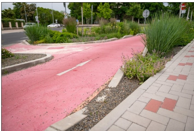
Obr. 72: Realizácia odtoku zrážkovej vody z chodníka (Roudnice nad Labem, ČR), zdroj: Adapteerra Awards - Nadace Partnerství (Vojta Herout)
