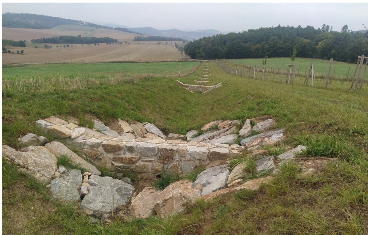
Obr. 66: Vytvorenie hrádzí pre zadržiavanie vôd v krajine na zvodnom priekope v katastri obce Jinačovice (ČR), zdroj: Adapterra Awards - Nadace Partnerství (Vojta Herout)
