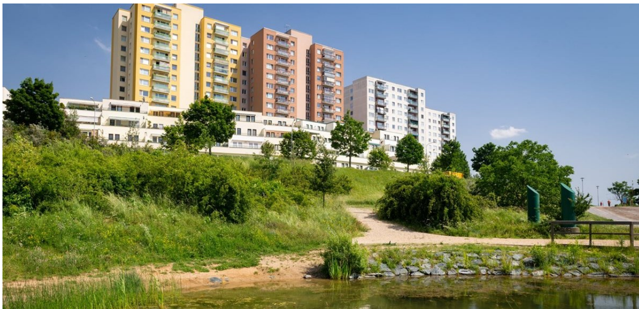
Obr. 71: Vodný biotop zásobovaný zrážkovou vodou zo striech bytových domov v susedstve (Nový Lískovec, Brno, ČR), zdroj: Adapterra Awards - Nadace Partnerství (Vojta Herout)
