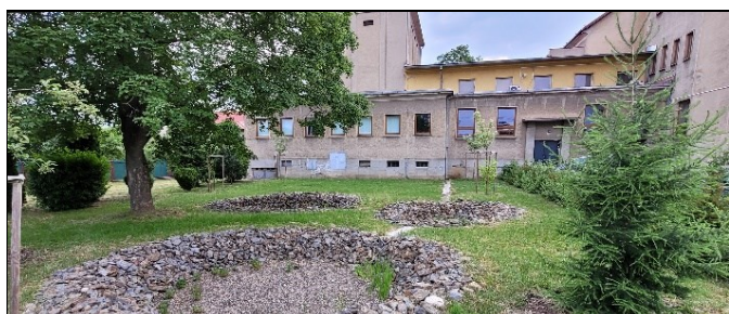
Dom kultúry – potreba znížiť energetickú náročnosť
