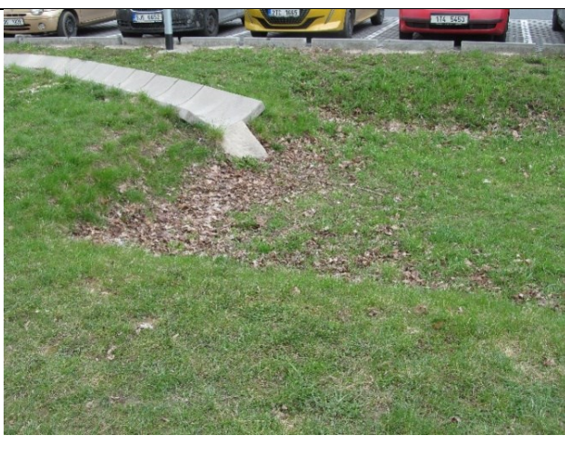
Obr. 72: Realizácia odtoku zrážkovej vody z chodníka (Roudnice nad Labem, ČR), zdroj: Adapteerra Awards - Nadace Partnerství (Vojta Herout)
