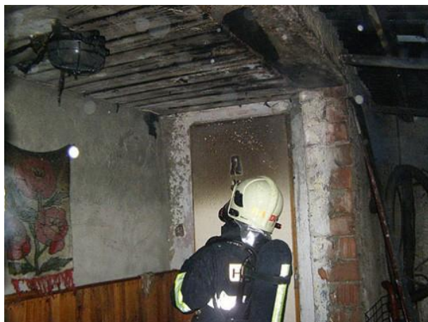
Požiar v priestore povaly spôsobený komínovým telesom
