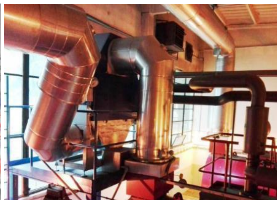
Doinštalovaný termokondenzátor
