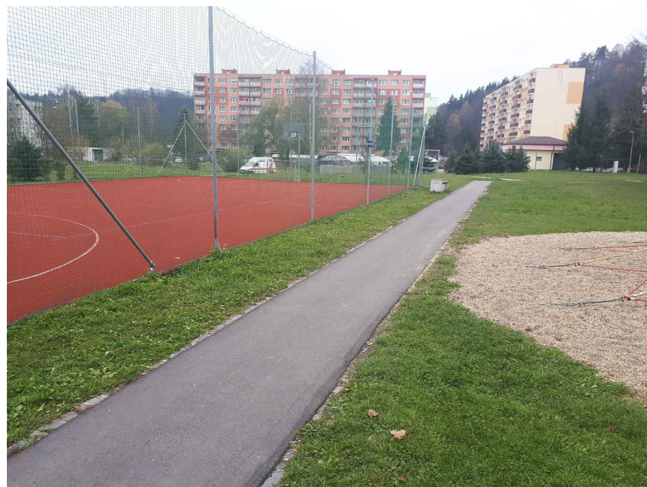
EXISTUJÚCE MULTIFUNKČNÉ IHRISKO - zachovalý stav
