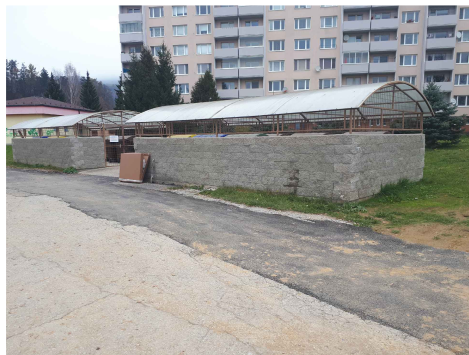
PRESTREŠENIE SMETNÝCH KOŠOV - nevhodné umiestnenie v strede vnútrobloku
