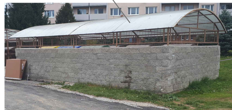
RENOVAČIA PRESTREŠENIA SMETNÝCH KOŠOV
